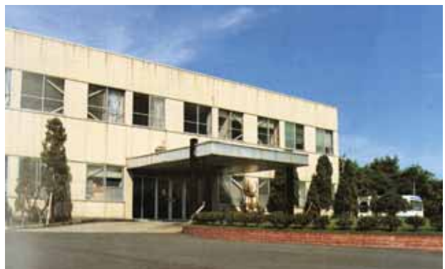
昭和61年頃の病院正面玄関
