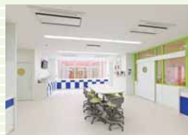
スタッフステーション
